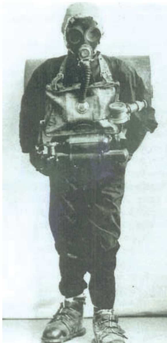
Guastatore Marciatore: recava, fissata sulla schiena, per mezzo di spallacci, una grossa carica esplosiva. Da notare la bussola posizionata per mezzo di una staffa in modo da facilitarne la lettura durante la marcia.
