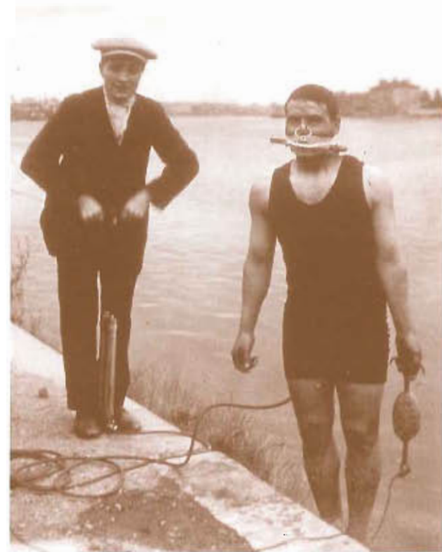
Fig. 3 - Sommozzatore con l'apparecchio Fernez per "immergersi a nudo" con assistente alla pompa per automobili
