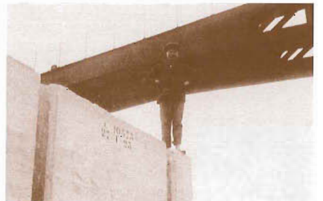
Ayub su uno dei blocchi di cemento utilizzati per costruire le dighe frangiflutti. Ayub on a concrete block, with the Stream crane in the background.
