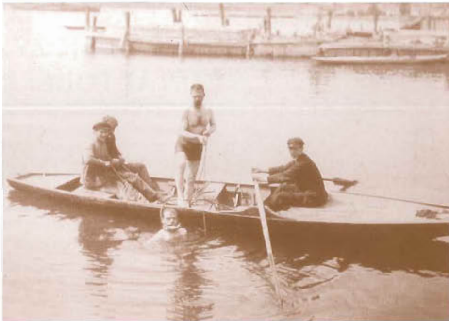
Fig. 2 - Un sommozzatore al lavoro equipaggiato con l'apparecchio Fernez per "immergersi a nudo"
