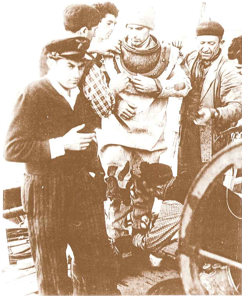
Anno 1957-Casalmaggiore (CR). Lavori di consolidamento del ponte sul Po. E' in atto la vestizione di Pino con la sistemazione del collare (alla quale seguirà il fissaggio dello scafandro). Si notino sulla muta le numerose "toppe" applicate per poterla sfruttare sino in fondo.
